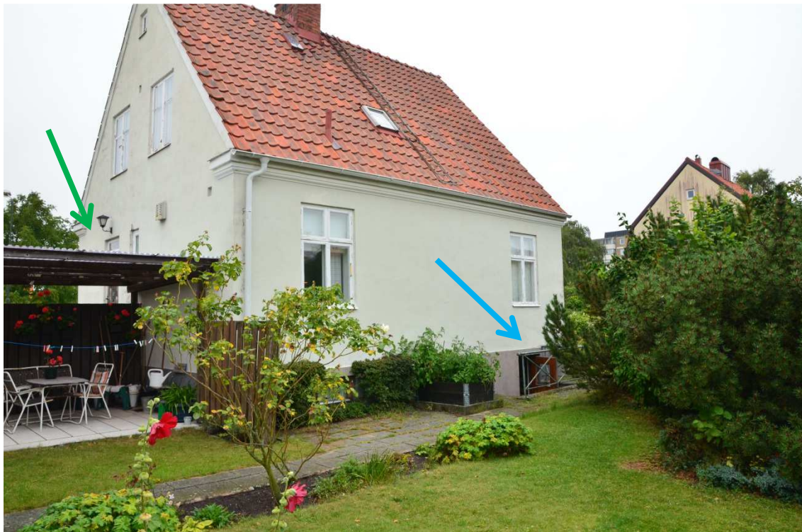
Bild 3: Fotograferat i riktning mot Marieholmsvägen och visar baksidan på huset.
