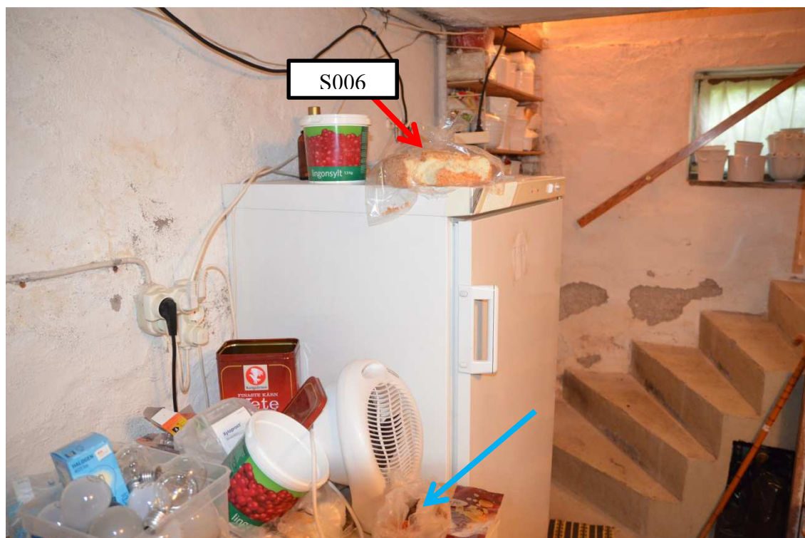
Bild 6: Fotograferad i riktning från tvättstugan mot trappan som leder upp till bottenvåningen.
